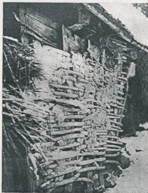
Detail pletené a vymazávané stěny chléva v čp. 24 ve Sv. Heleně. Foto Skalníková.
